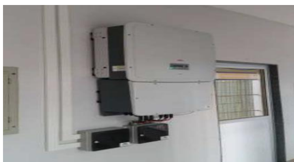
Figura 16 - Equipamento Inversor de frequência que absorve e faz a conversão da energia contínua captada pelos painéis solares em energia elétrica alternada utilizada no sistema predial – HU-UFMA
