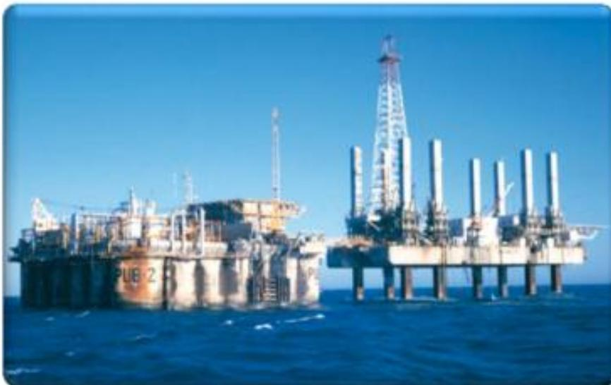
Foto: Plataforma fixa de concreto e auto-elevatória de Ubarana
